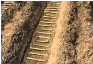
Planting dans les tranchées
